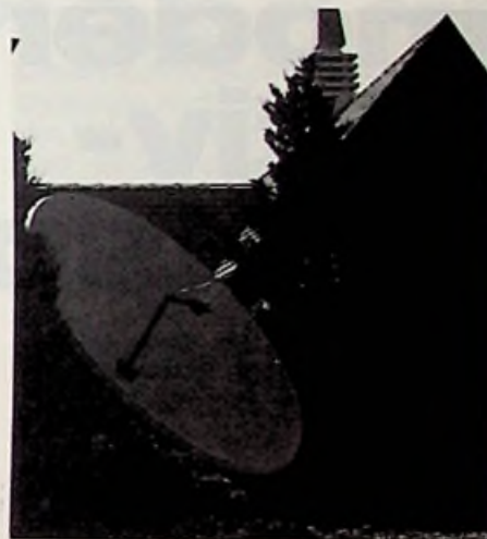
Bild 7: Neben Stahl und Aluminium ist glasfaserverstärkter Kunststoff mit Oberflächenmetallisierung ein häufig verwendeter Werkstoff für Parabolantennen
